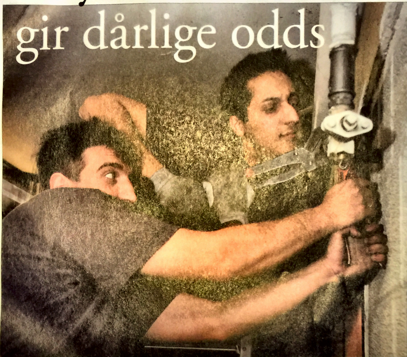
Kjekt med fire hender når rør skal installeres. Rørlegger Sladan Milanovic (til venstre) gir Ramiz Safdar ei hjelpende hand.
